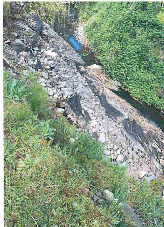
A bal parti kőfal károsodott szakasza, alvizi irányból nézve (2024.04.22.)
