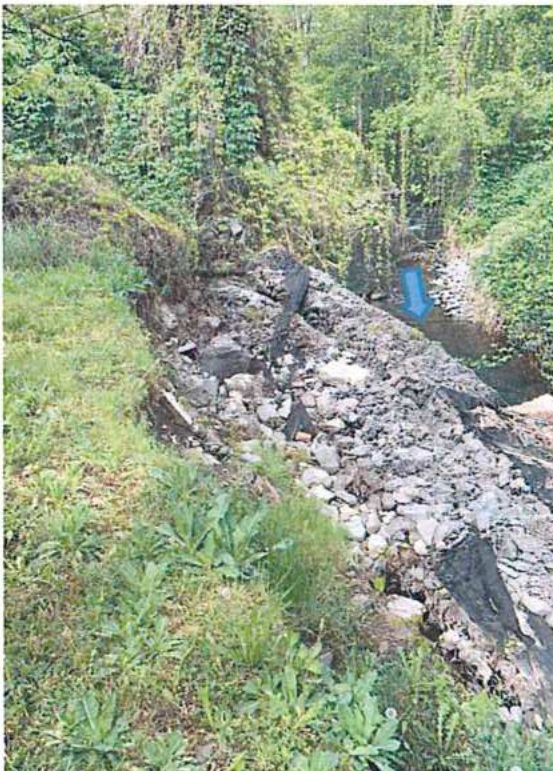
A bal parti kőfal károsodott szakasza, alvizi irányból nézve (2024.04.22.)
